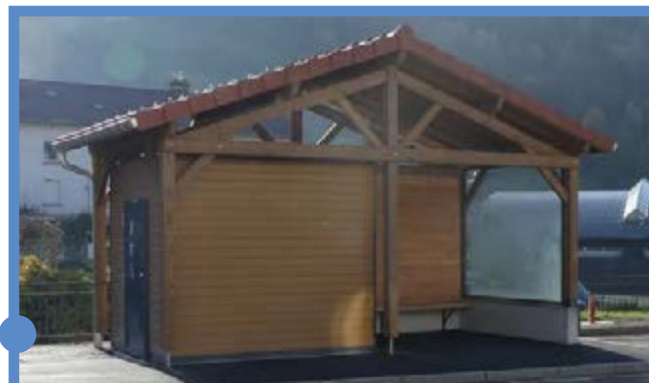
▲ Dans le cadre de l'amélioration des infrastructures, l'arrêt de bus «Arrêt du Champtel» ainsi que le WC public, ont été refaits à neuf.
