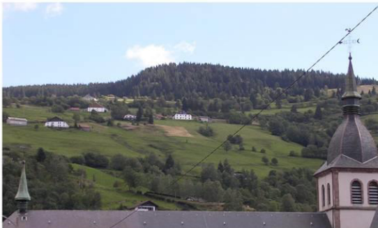
Implantation du bâti traditionnel sur le versant.
