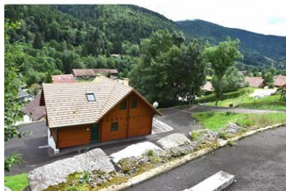
Chemin du Nol, imperméabilisation des sols
