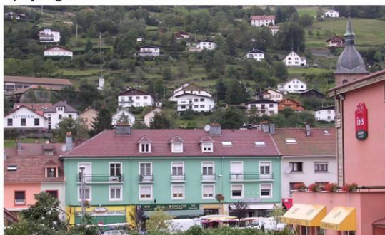
Ravalement de façades, quai des Iranées.
