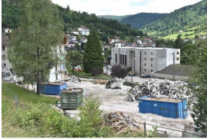
Démolition de bâtiments d'habitat collectif Rue de la Résistance
