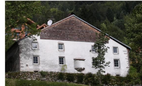
Four à pain formant une saillie semi-cylindrique en façade.
