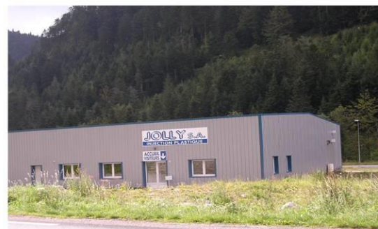
Bâtiment en bardage métallique, sans aucune référence architecturale.
