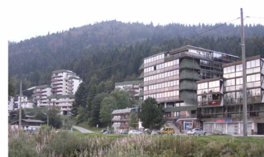
Belle Hutte : façade de verre et immeuble avec toiture terrasse.
