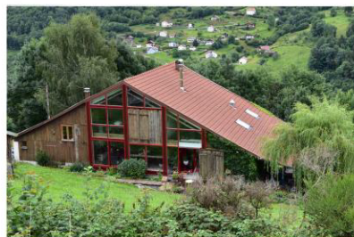
Création d'imposantes baies vitrées en façade Aspect brillant des éléments techniques en toiture
