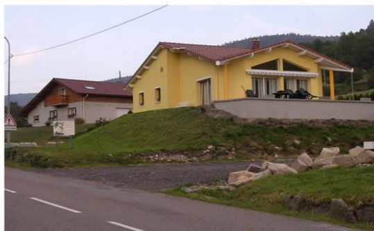
Complexité des toitures et couleur vive des enduits.
