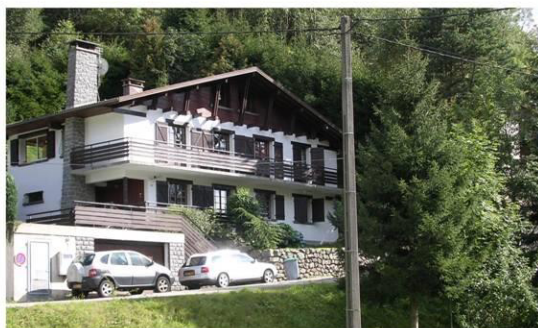
Rue des Roches Beuty : muret en pierre et garage.
