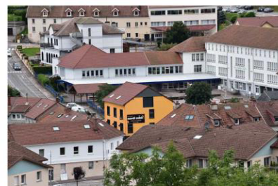
Couleur de l'enduit de façade
