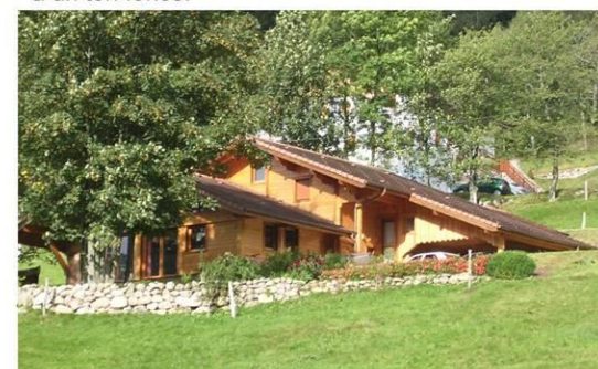
Bonne échelle du mur de soubassement.
