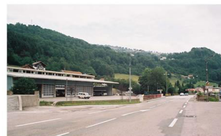
RD 486, à la hauteur du panneau d'entrée d'agglomération en provenance de Cornimont - Vue 3
