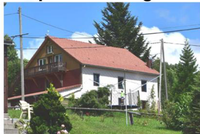
La Basse des Feignes Double comble et accès extérieur sur mur pignon
