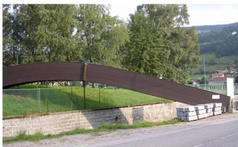
Passerelle bois franchissant le Chajoux.
