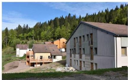
Travaux en cours au col des Faignes sous Vologne
