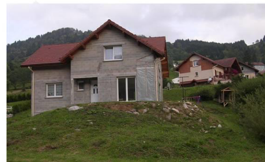
Pas de faîtage principal.
