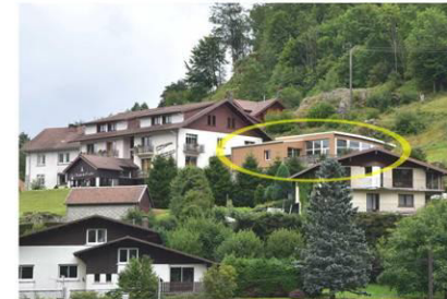
Extension de la structure hôtelière, rue des Noisettes
