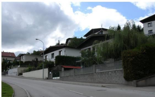
Mur à enduire, rue Mougel Bey.
