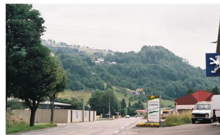
RD 486, à la hauteur du panneau d'entrée d'agglomération en provenance de Cornimont - Vue 2
