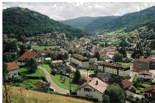
Photographie août 2004 (vue depuis RD 486)
