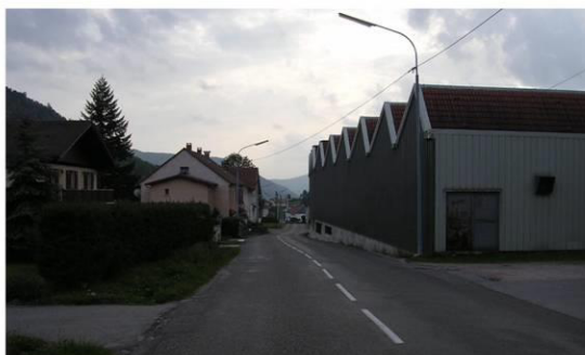
Usine au Pré Marion, bordant la voie et présentant des sheds.
